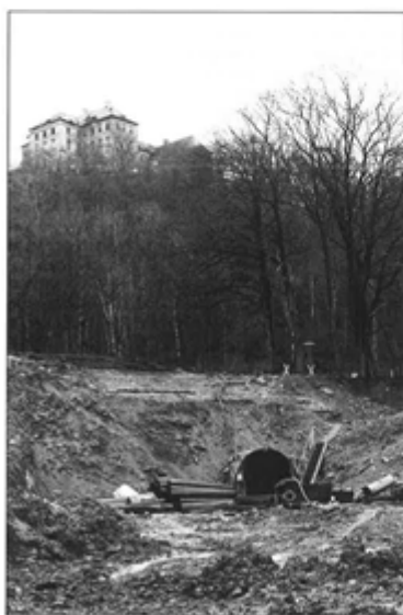
Obr.5 Průzkumná štola pod zámek Jezeří
