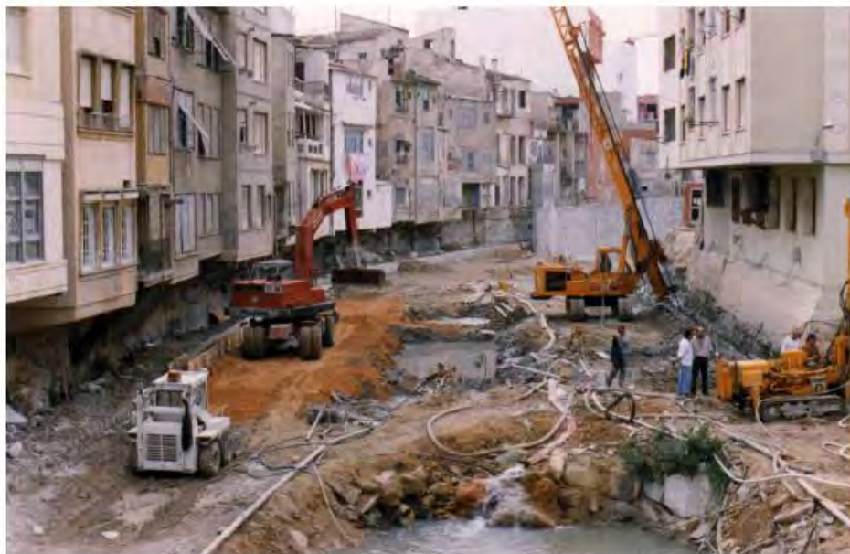
Staveniště regulace řeky Segury v historické zástavbě města Orihuela. Foto Otto Horský, 1993.
