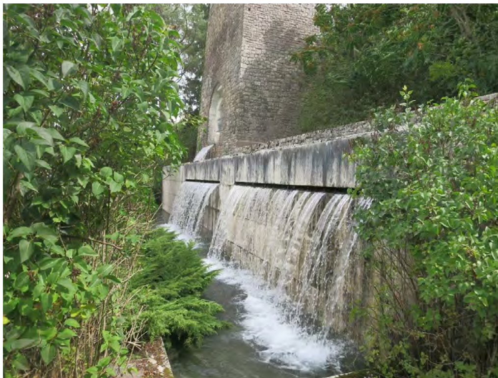
Peschiera – výtok zachycených krasových vod pro zásobování Říma pitnou vodou
