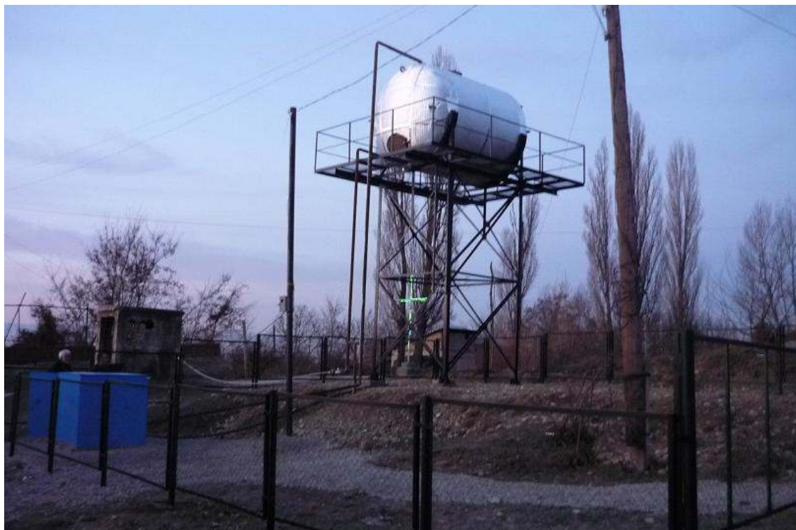
(obr. 4) Konečný stav: vrt osazený čerpadlem (v modré boudě), vodojem.
