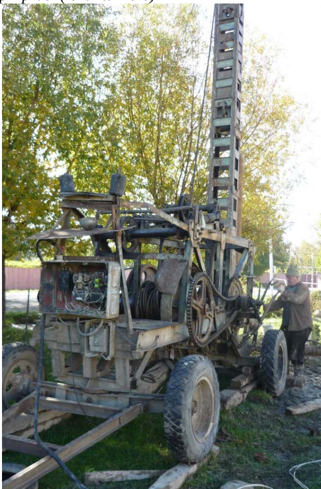
(obr. 3) Vrtné práce probíhaly úspěšně i za použití této starodávné nárazové soupravy.
